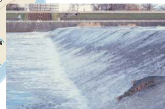
サケが上れない人工の段差（床止め）
